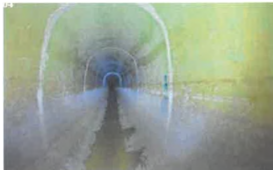
Колектор, реавилигиран чрез обличане с овални тръби GRP
