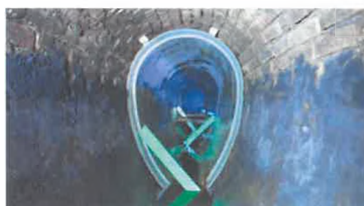
Безизкопна технология - релайнинг с тръби PAFSIN GRP
