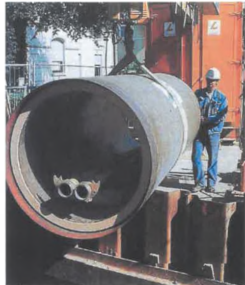
Тръба от полимербетон DN 1000 със стоманена връзка
