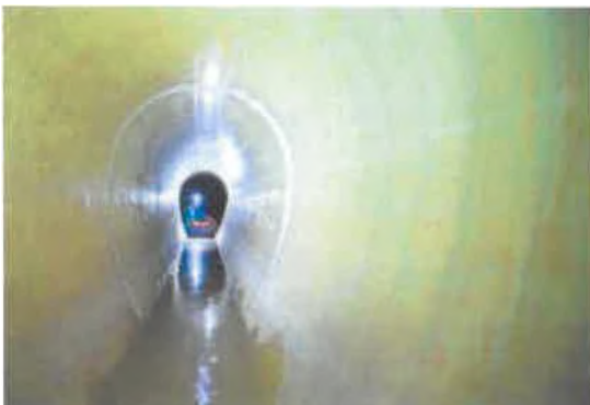
Монтаж на тръби GRP с яйцевидна форма
