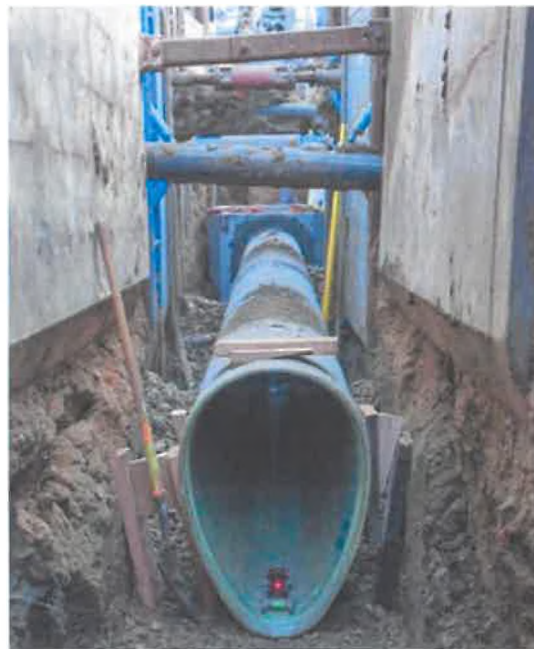
Изграждане на GRP тръби по метода с отворен изкоп
