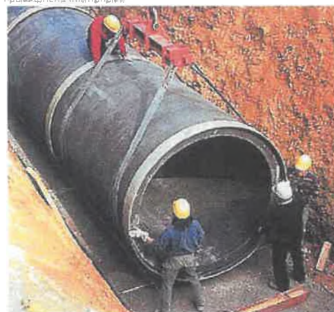
Полагане на колектор от полимербетон DN 2000
